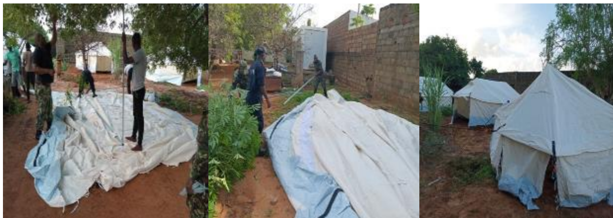
Figura 44-Montagem de tendas no centro de acomodação Capelinha na zona do Romão – Kamavota
