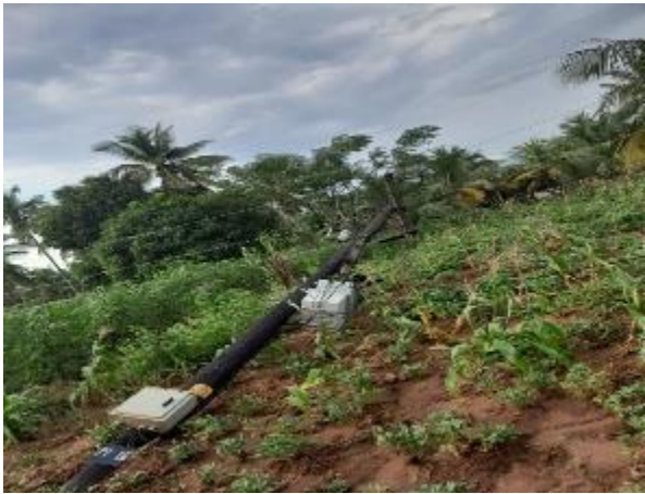
Figura 41-PT no Chão na zona de Morrumbene, Inhambane
