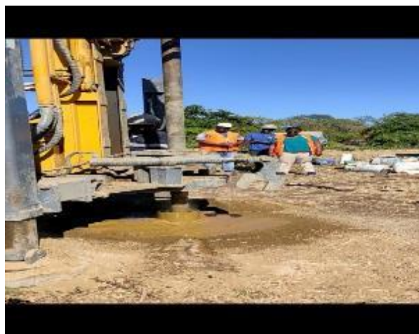
Figura 54-Abertura furo de água no Distrito de Marara, Tete
