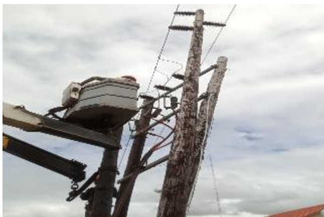
Figura 50-Trabalhos de reposição no PT Bombagem de água, bairro chibuenhe
