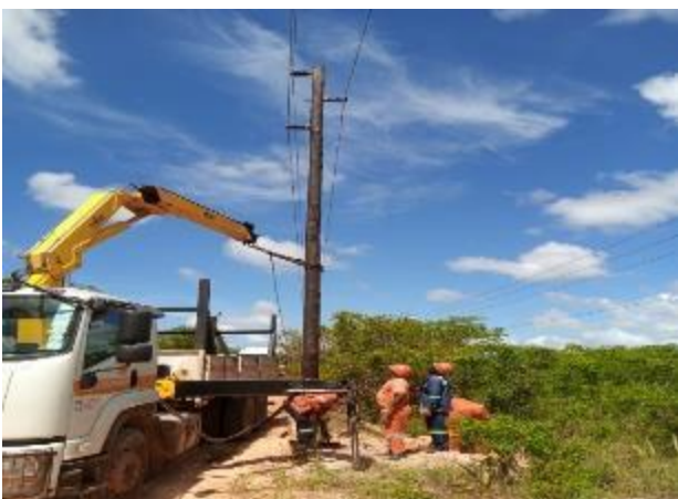
Figura 49-Trabalhos de reposição na EL1 zona de Temane 9
