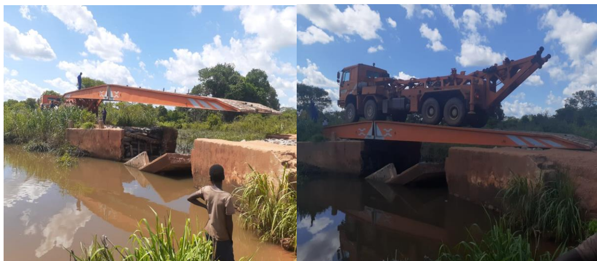
Figura 36- Montagem da ponte em Liupo
