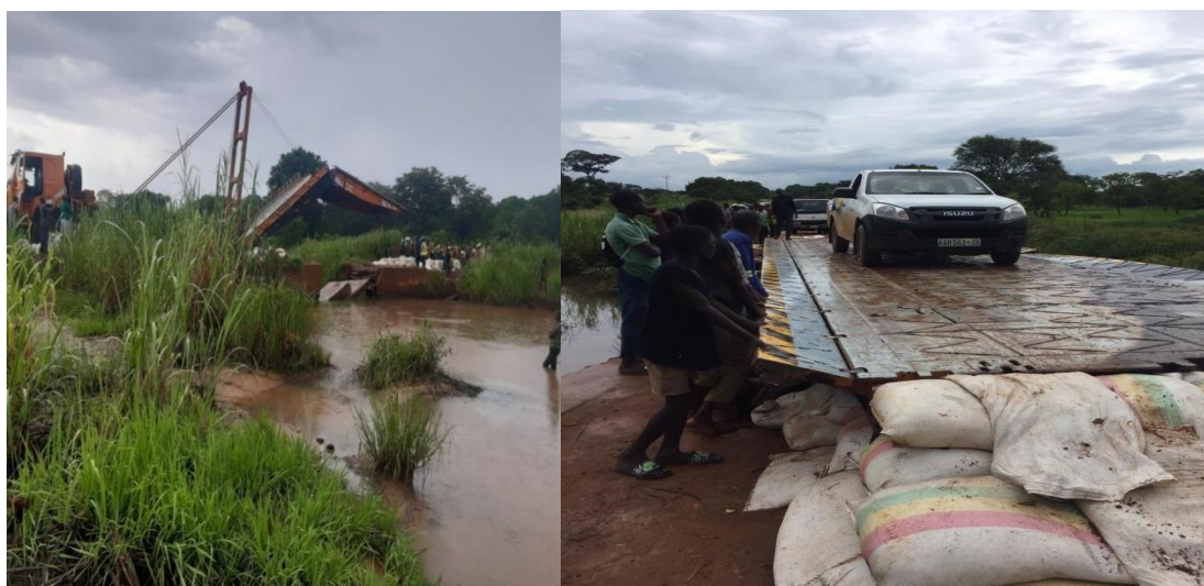
Figura 38- Montagem da ponte em Mavago Niassa.
