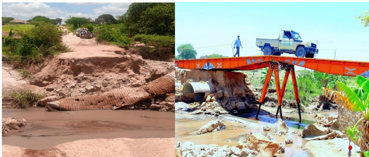
Figura 37- Montagem da ponte no troço que liga Nacala-velha – Memba
